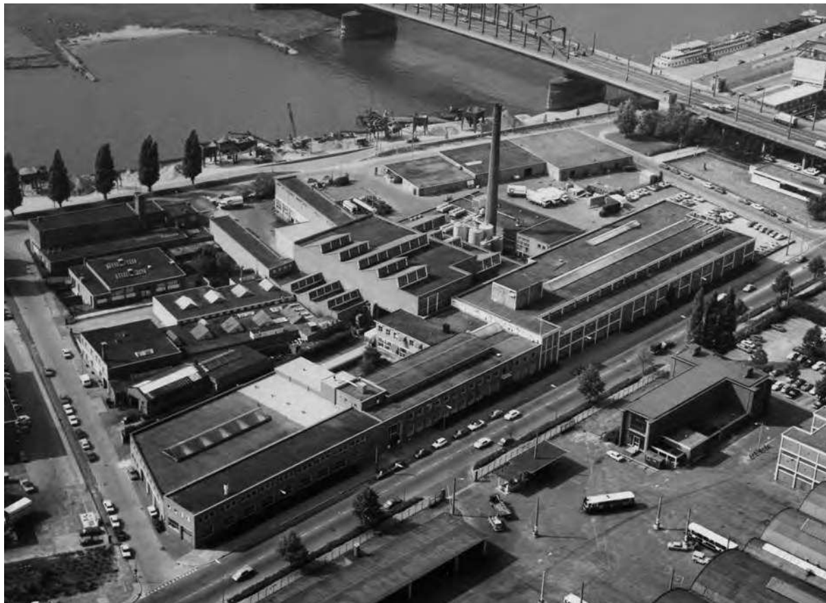
Luchtfoto van de Coberco-fabriek aan de Westervoortsedijk in Arnhem (1980) (Collectie Klaas de Wit)
