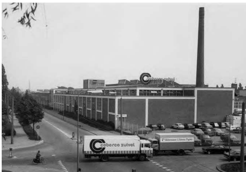
Na de fusie van Vecomi Arnhem en Coberco Zutphen in 1972 prijkte de merknaam Coberco op de melkfabriekspanden aan de Westervoortsedijk. (Foto: Collectie Klaas de Wit).
